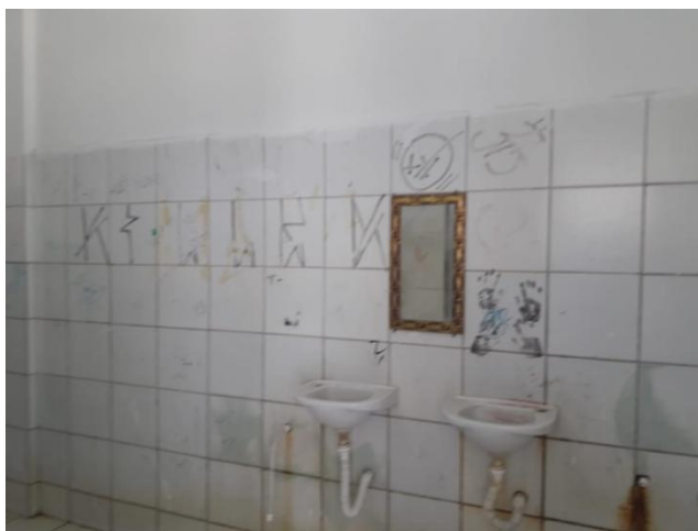
Imagem de um dos banheiros da escola
